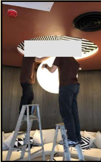
ช่างอาคารฯทำการเปลี่ยนหลอดไฟ โคมไฟใหญ่ ทดแทนของเดิมที่ เสื่อมสภาพ บริเวณโถงรับรองชั้น G
