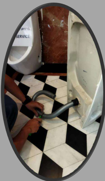
ช่างอาคาร ทำการต่อท่อปัสสาวะ เนื่องจากน้ำรั่ว บริเวณห้องน้ำชายชั้น สระว่ายน้ำ
